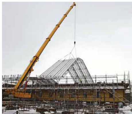
Byggnadsarbetarna från Thage Andersson Bygg i Tollarp hade ett svårt jobb. När sönderblåst plast skulle bytas ut tog vinden fatt i sektionen.
